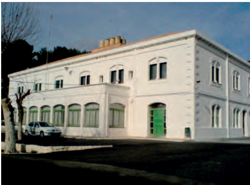
Fachada exterior de la residencia de marinería
