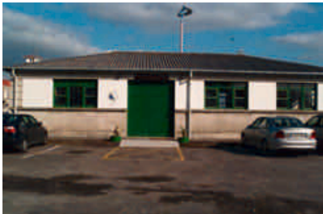
Vista de la entrada del edificio del núcleo de goletas
