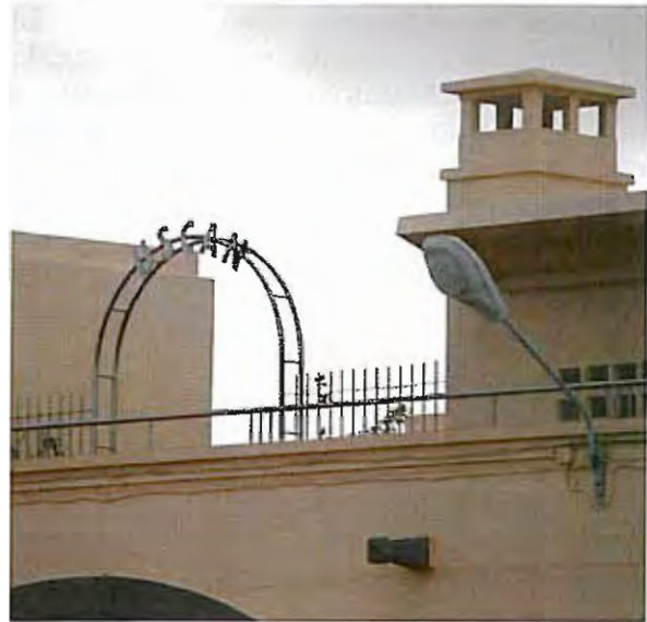
Puerta de la Antigua Agrupación en el barranco de Guanarteme, y acceso a la primera planta del edificio de mando de la USCAN en su actual emplazamiento.
